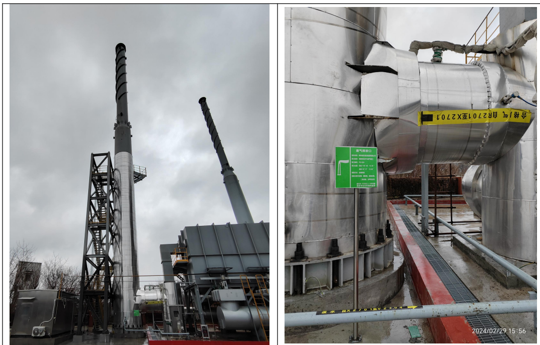
图 3-2 废气采样点及环保标识牌
