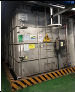
废碱液暂存现状
