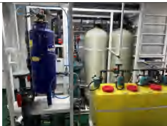
图 6.1-6 施工船舶油水分分离器
