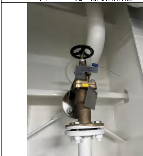
图 6.1-7 施工船舶油水分分离器铅封
