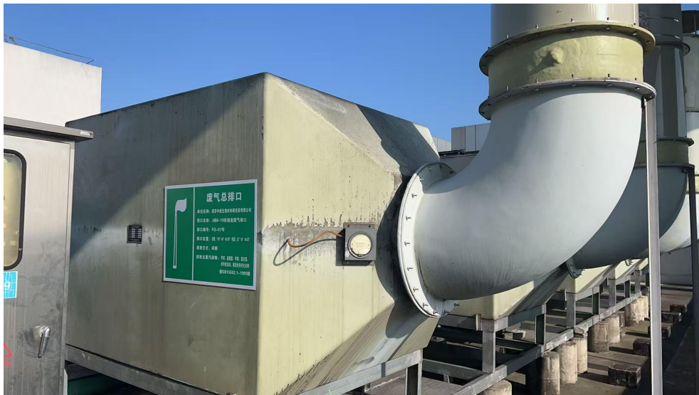
图 3-3 本项目废气处理设施
